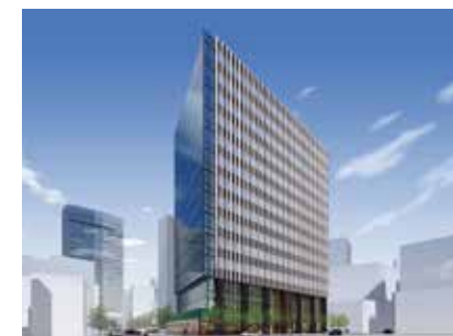
第2名古屋三交ビル(建設中)
