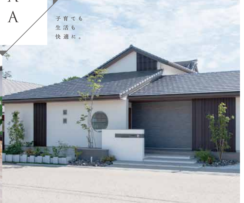
※写真は施工事例です。
