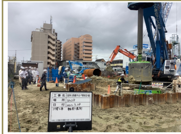
試験杭 立会状況
