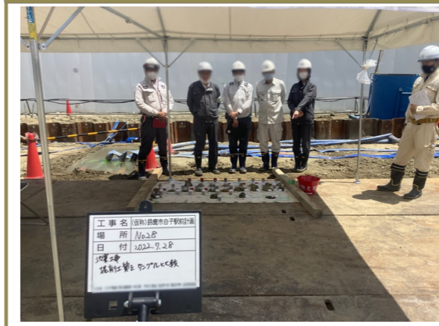
試験杭 立会状況
