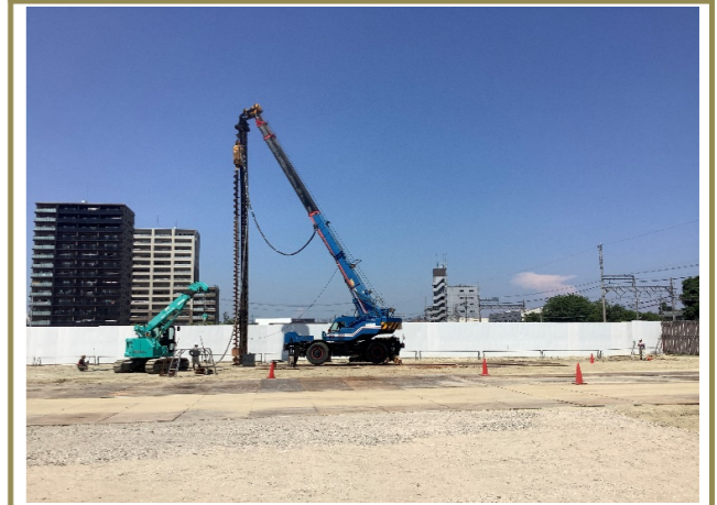
土留工事 施工状況
