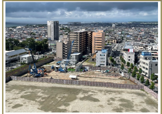
定点写真(北側より)
