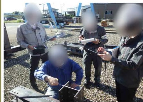
外構鉄骨製品検査
