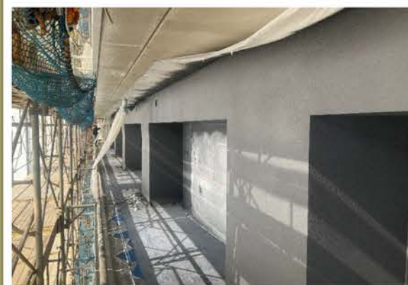
外装吹付タイル施工状況
