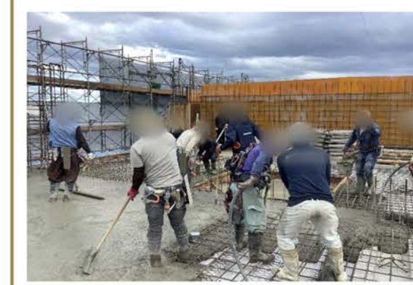
14階床1通～7通コンクリート打設
