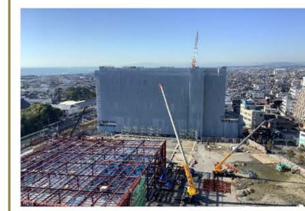
定点写真(北側より)
