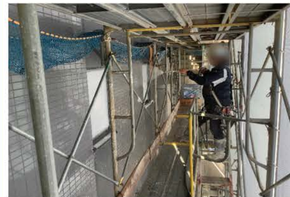
外壁散水試験状況
