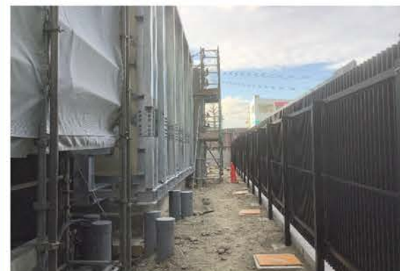
隣地イオン取合い外構仕上げ状況
