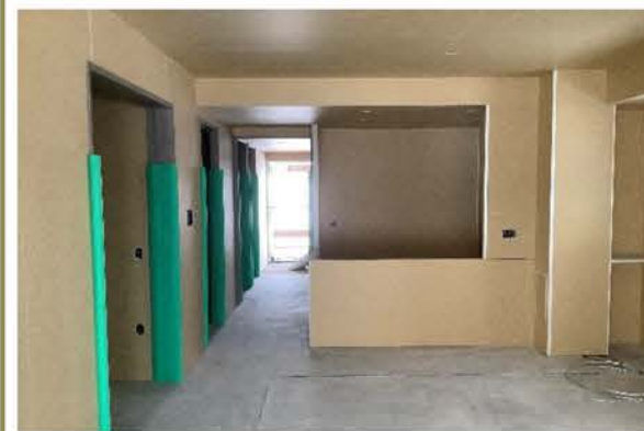
3階専有部ボード張り状況
