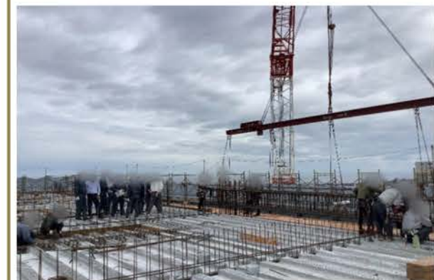
現場施工見学会状況
