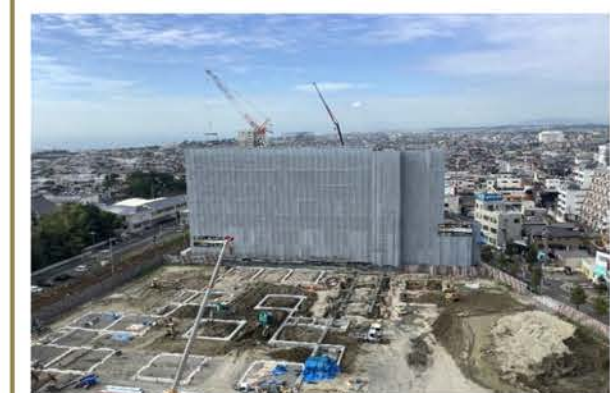
定点写真(北側より)
