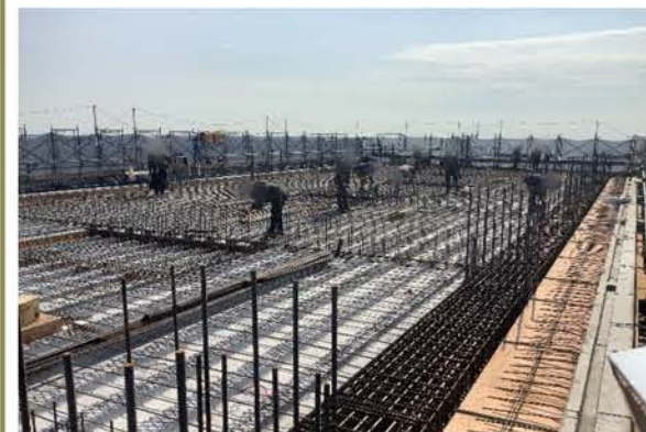
13階床鉄筋組立状況
