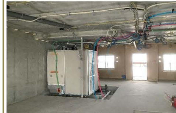
5階専有部ユニットバス据付状況
